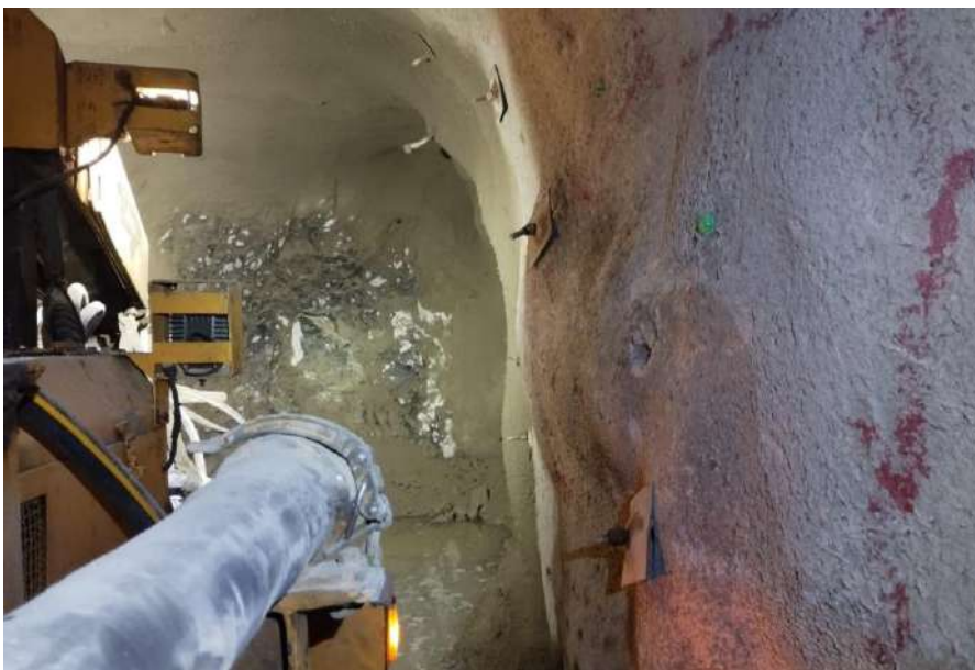
Figura 24. Labor con shotcrete
