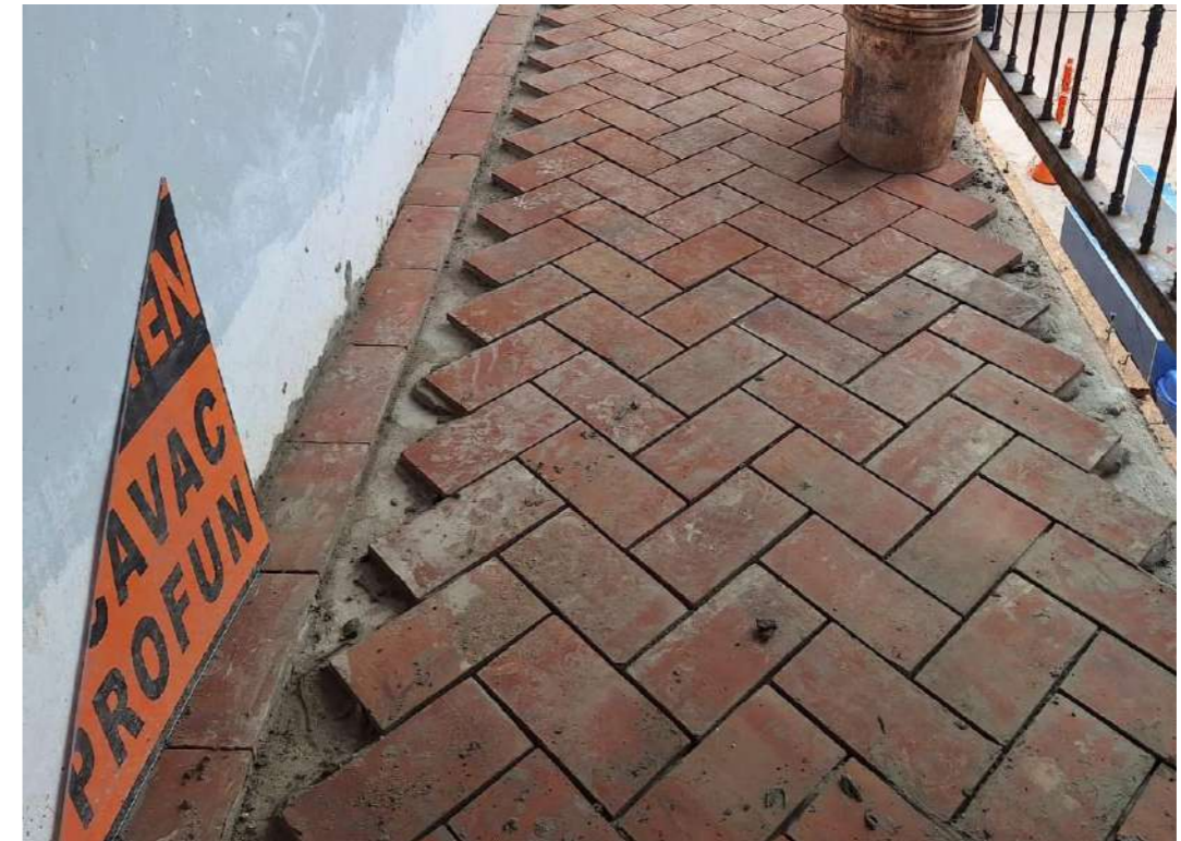
Figura 31. Piso de cerámico imitación del ladrillo pastelero
