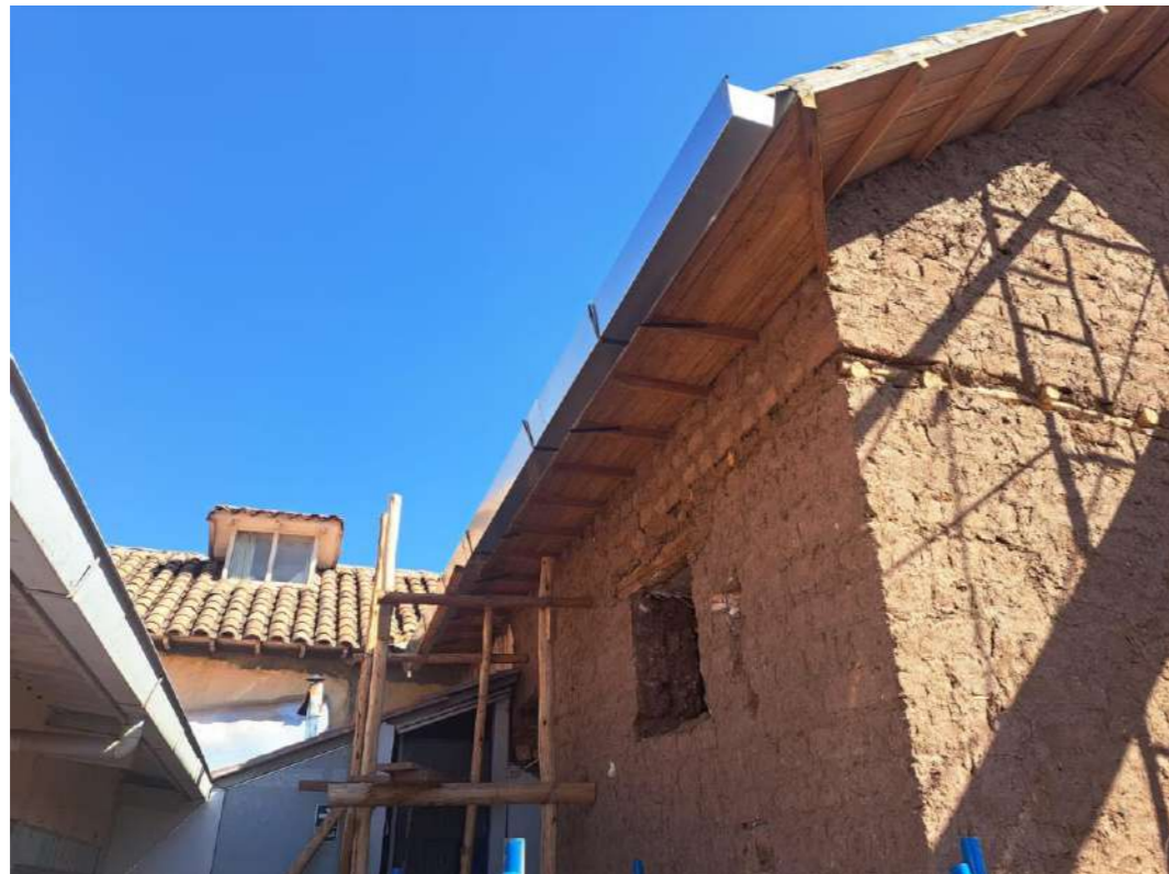
Figura 23. Restitución de muros de adobe- amb. 217
