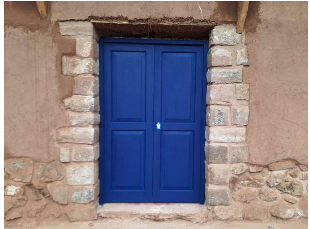
Figura 54. Restitución de jambas de piedra
