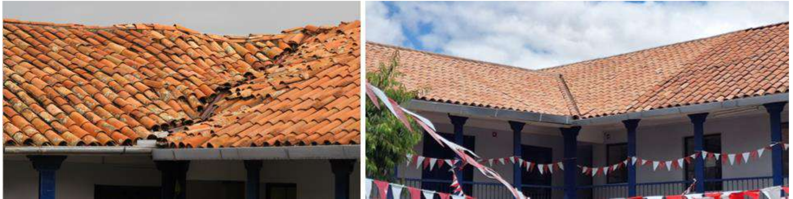
Figura 59. Antes y después de cubiertas - amb. 217 y 218
