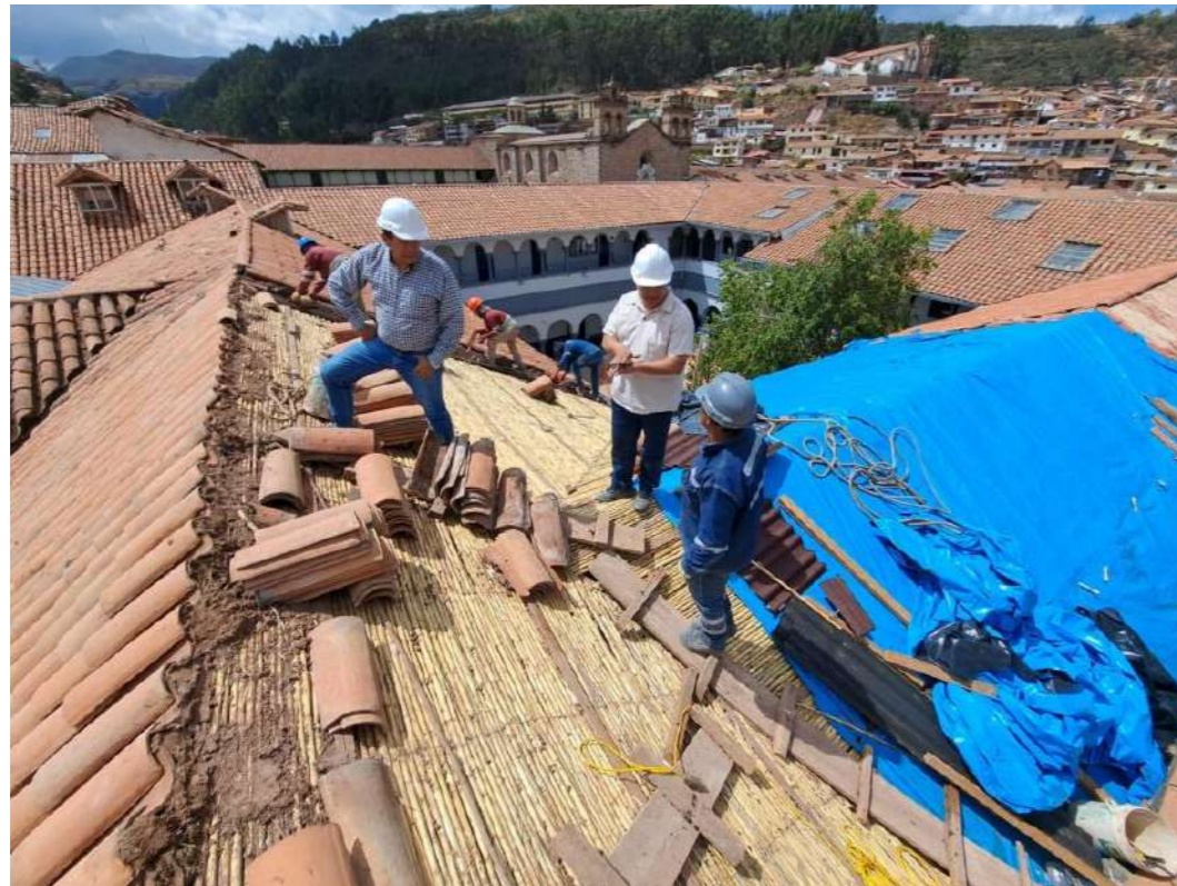
Figura 16. Restitución de cubierta de teja tipo colonial amb. 217
