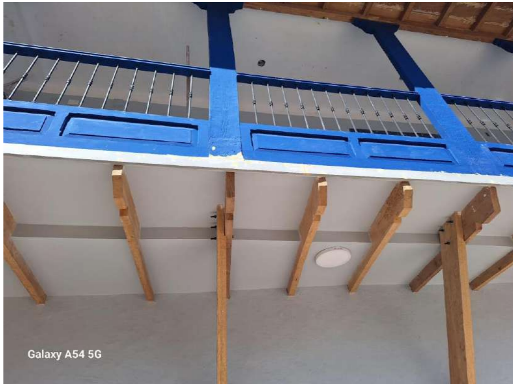
Figura 37. Pintura en estructura de madera - amb. 202
