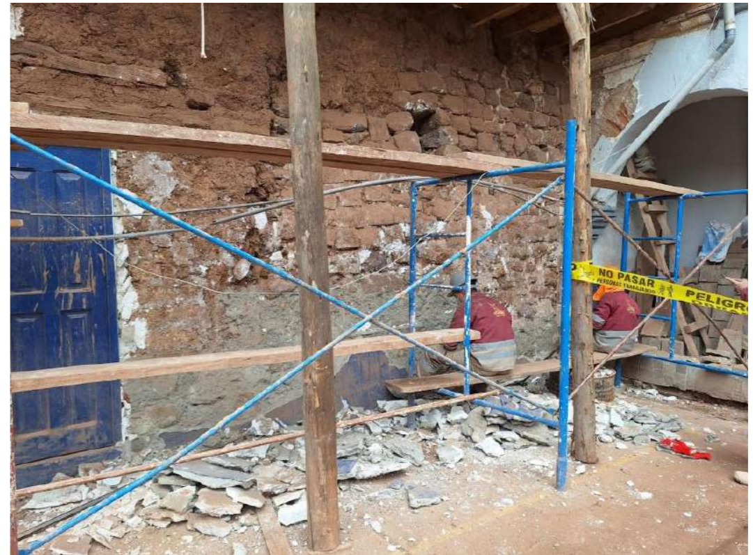
Figura 50. Liberación de zócalos de concreto - amb. 116
