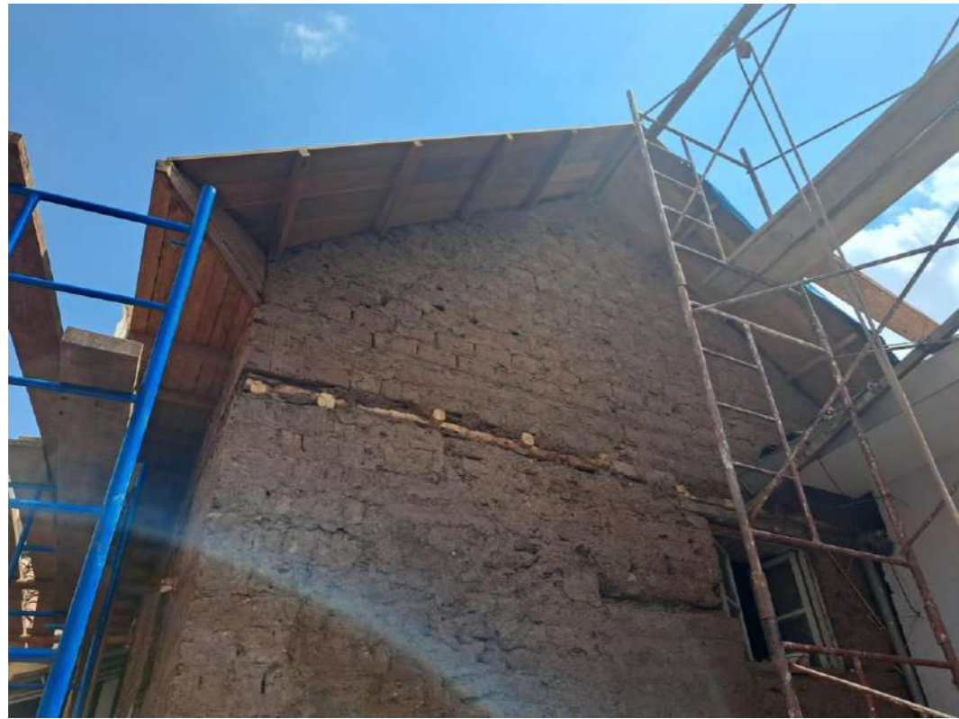
Figura 22. Restitución de muros de adobe- amb. 217
