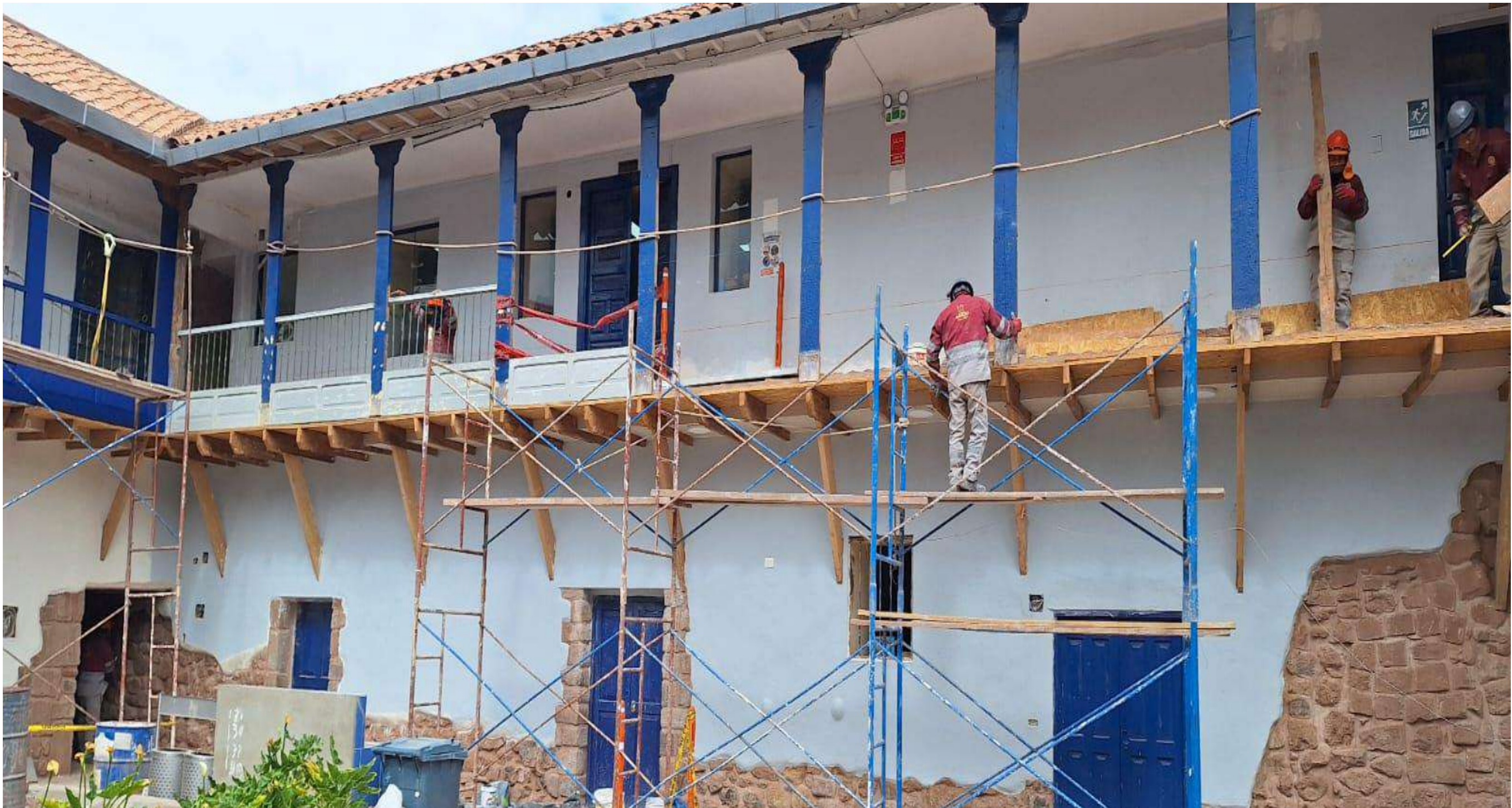
Figura 35. Restitución y Restauración de balaustrada de madera y metal - amb . 203
