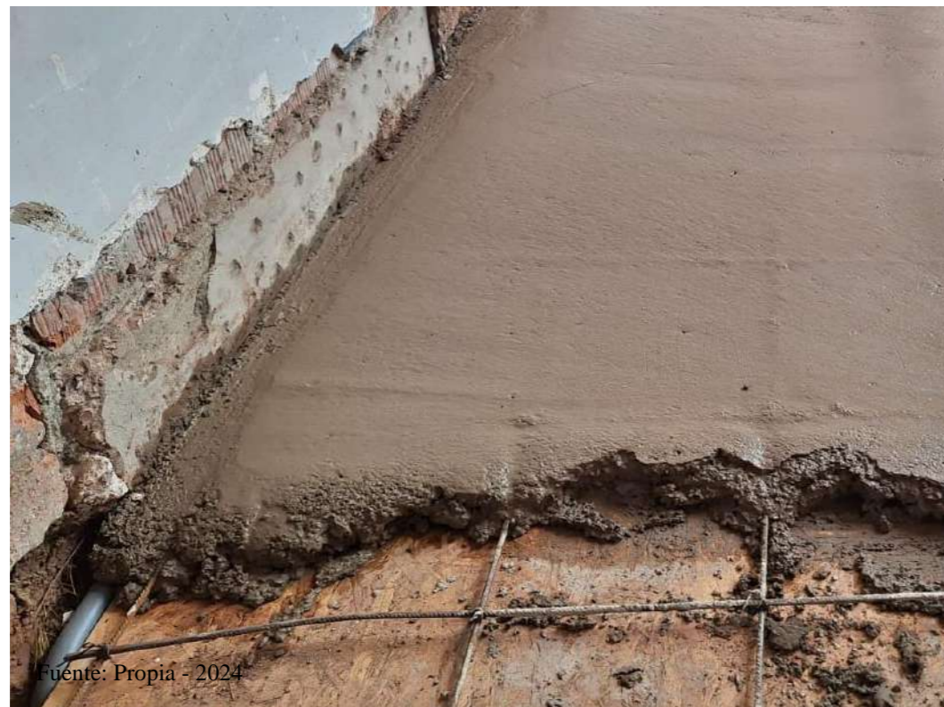
Figura 30. Puente de adherencia de 5cm con acero de temperatura
