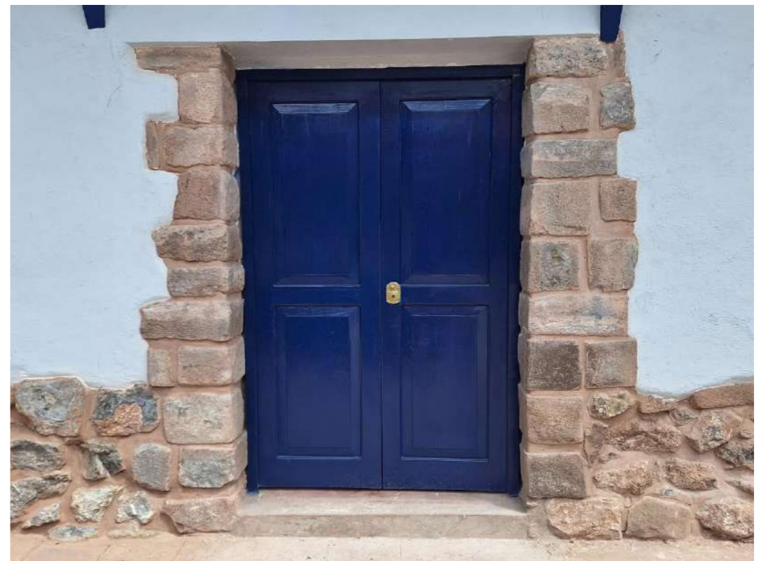
Figura 55. Restitución de puertas de tablero rebajado
