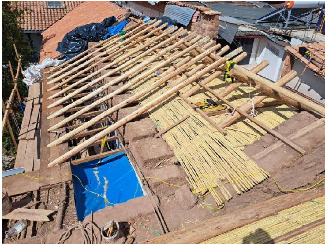
Figura 11. Encarrizado de cielorraso y faldones - amb. 217
