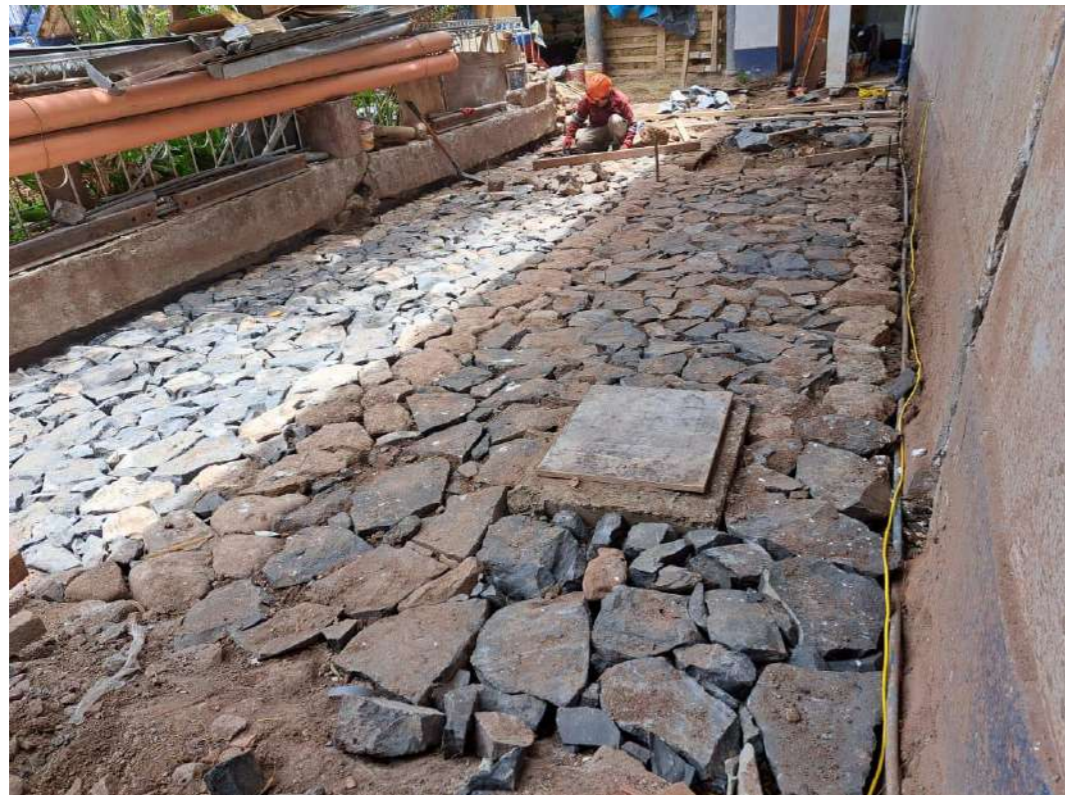
Figura 45. Falso piso de 2" de concreto
