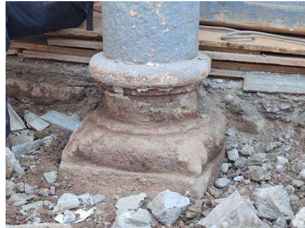
Figura 42. Liberación de basas de columnas - amb. 117
