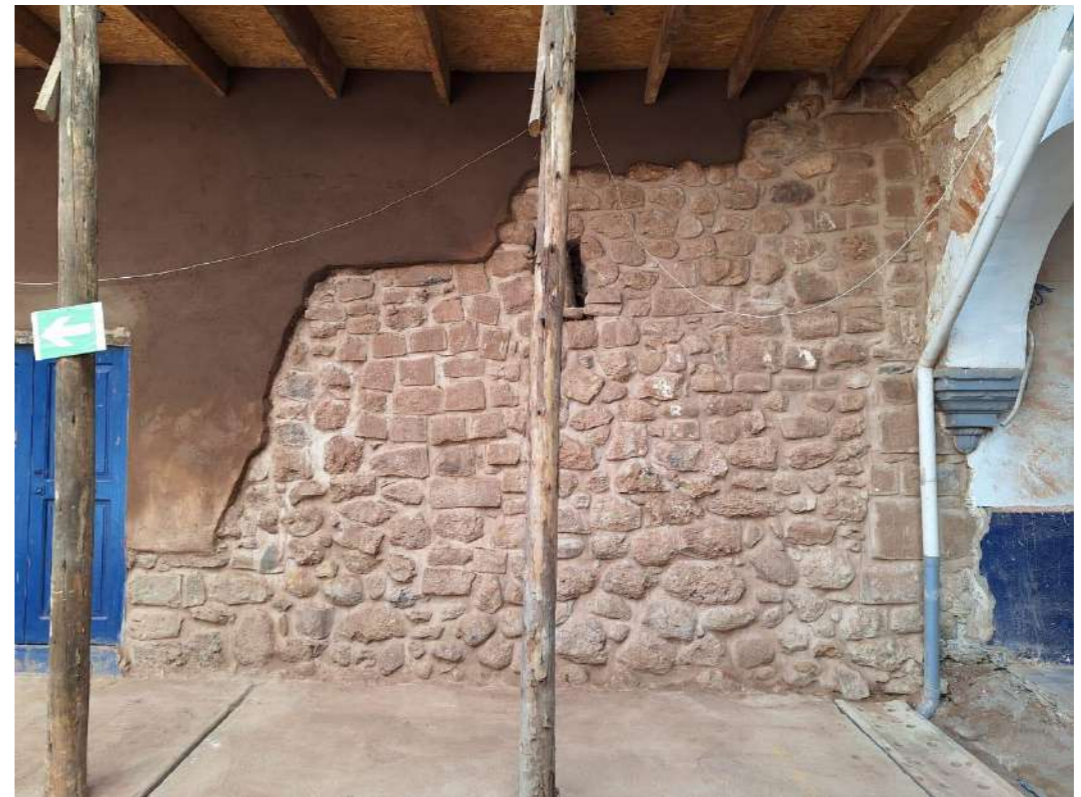
Figura 51. Emboquillado y embarre en muros amb. 116
