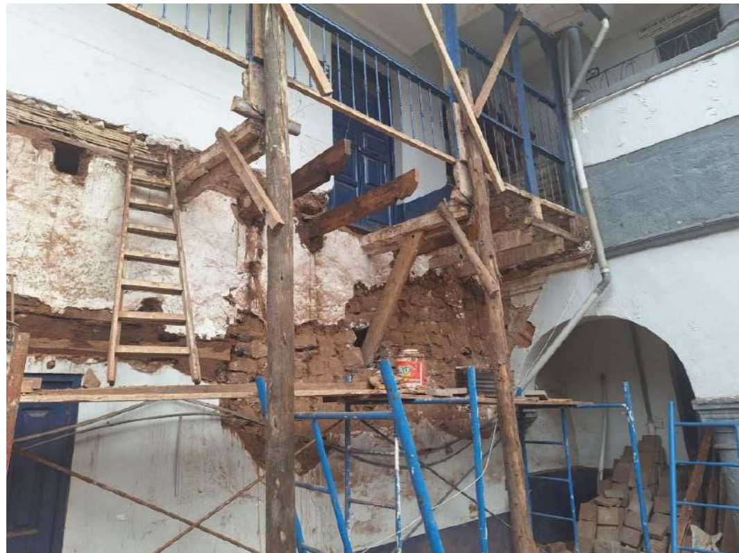
Figura 49. Liberación de revestimientos amb. 116
