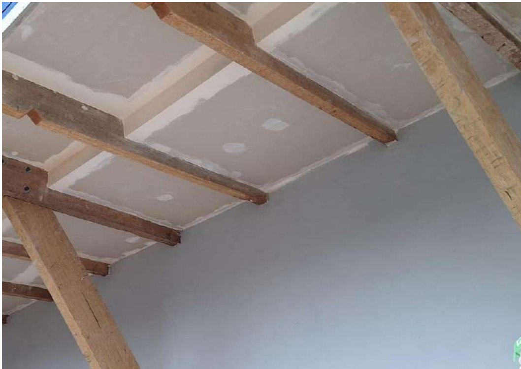
Figura 36. Falso cielo raso de drywall - amb. 202
