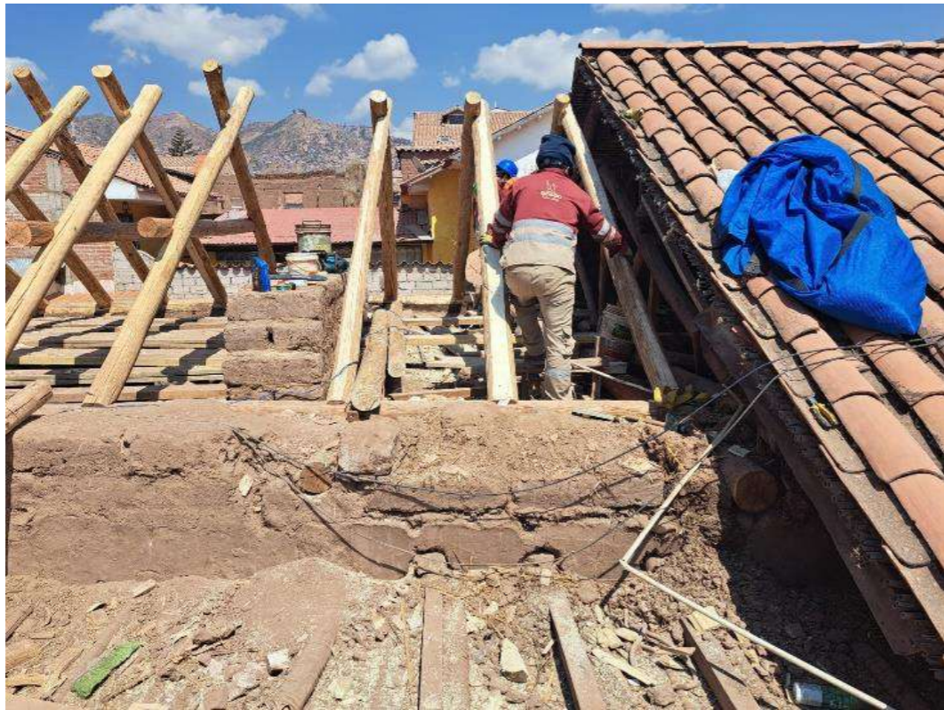
Figura 7. Restitución de estructura de madera - amb. 217
