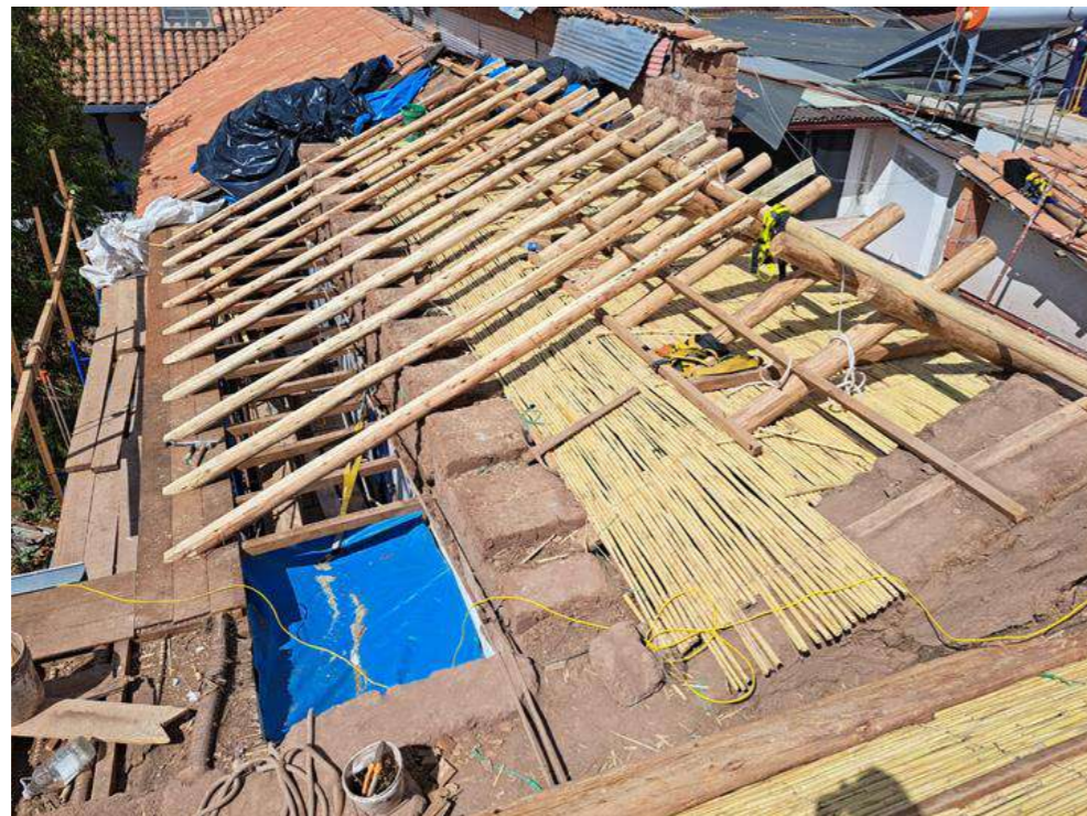
Figura 5 Liberación de enlucidos y coberturas en los ambientes - 116, 202 y 218
