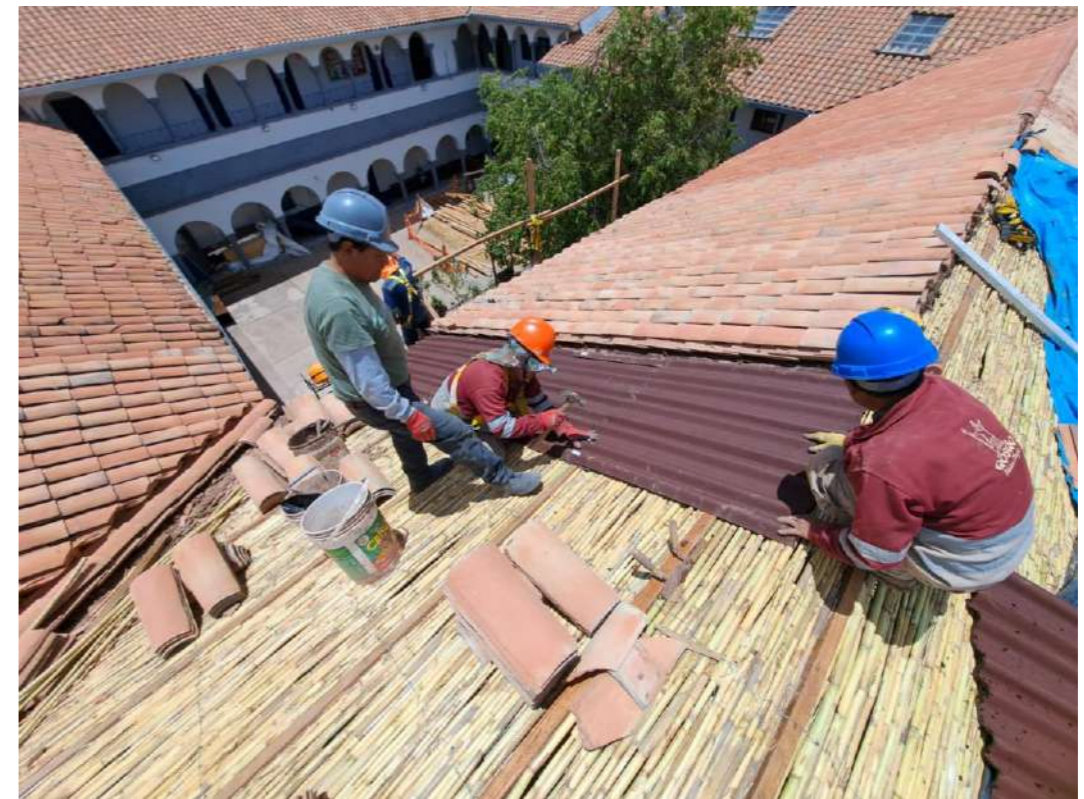
Figura 17. Restitución de cubierta de teja tipo colonial amb. 218
