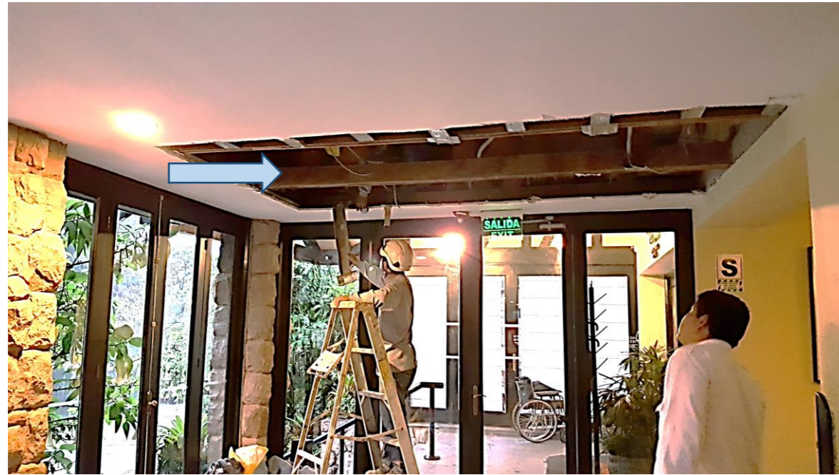
Figura 10: Desmontaje de falso cielo raso de drywall.
