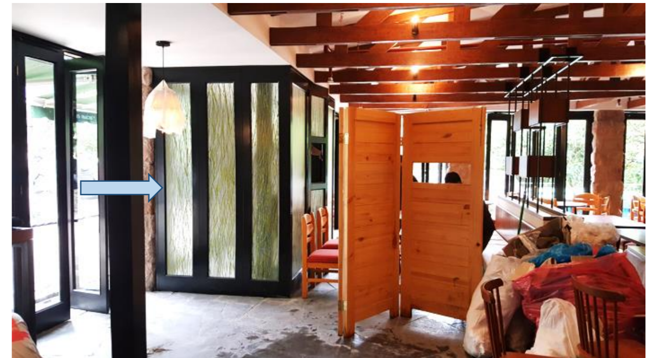
Figura 48: Fabricación de espacio de heladería con triform en lugar de vidrio.
