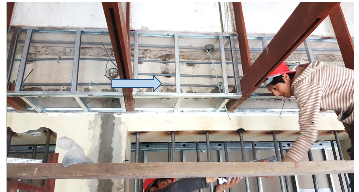
Figura 24: Armado de estructura para drywall en falso cielo raso para luminarias de mesas.
