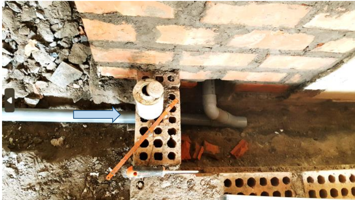
Figura 43: Entubado de desagüe de jardineras, picado y entubado.
