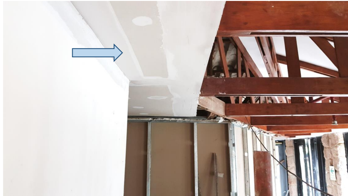
Figura 25: Instalación de drywall, enmallado y masillado.
