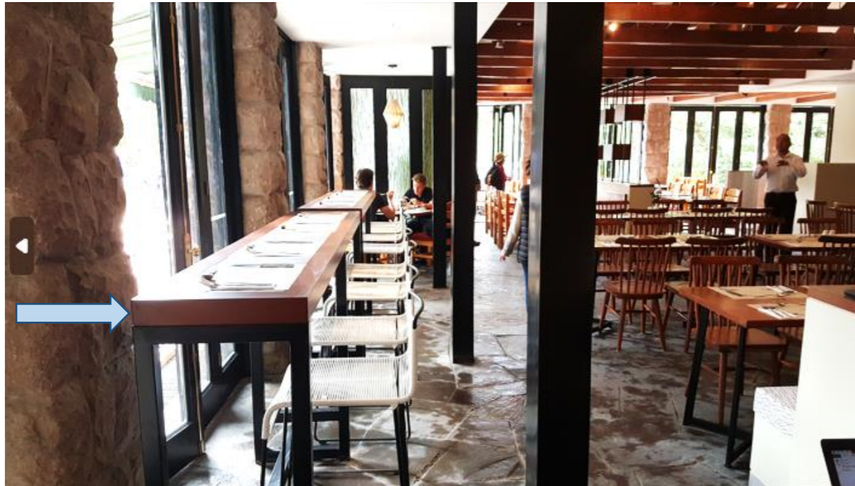
Figura 49: Fabricación de mesas tipo barra para comedor y pintado de vigas de madera.
