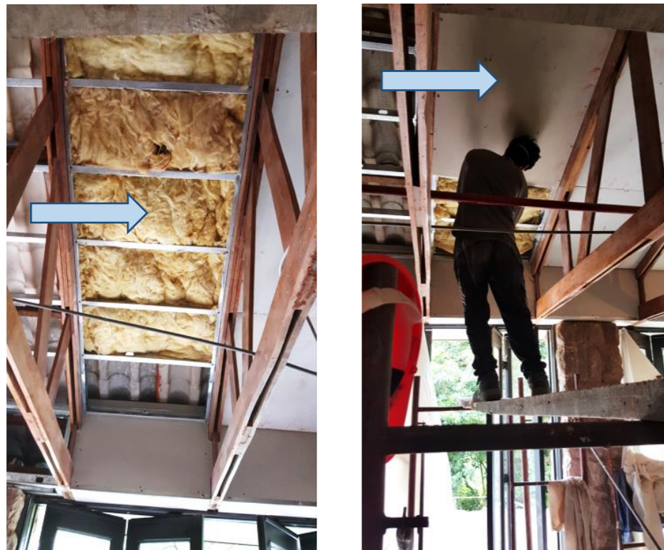
Figura 26 y 27: Instalación de lana de vidrio y posterior emplacado de fibra de cemento en cielo raso.
