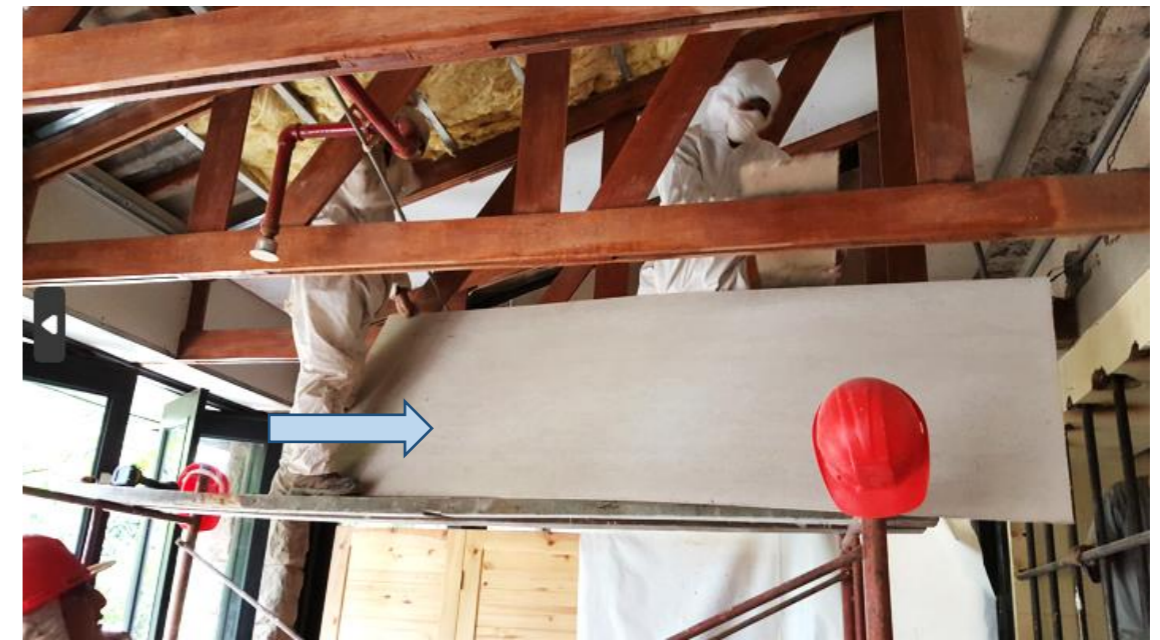
Figura 28: Emplacado de fibra de cemento en cielo raso ente tijerales de techo existente.
