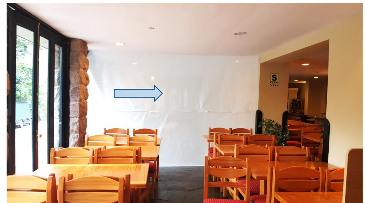
Figura 15: Cerramiento hacia fachada y parte posterior.
