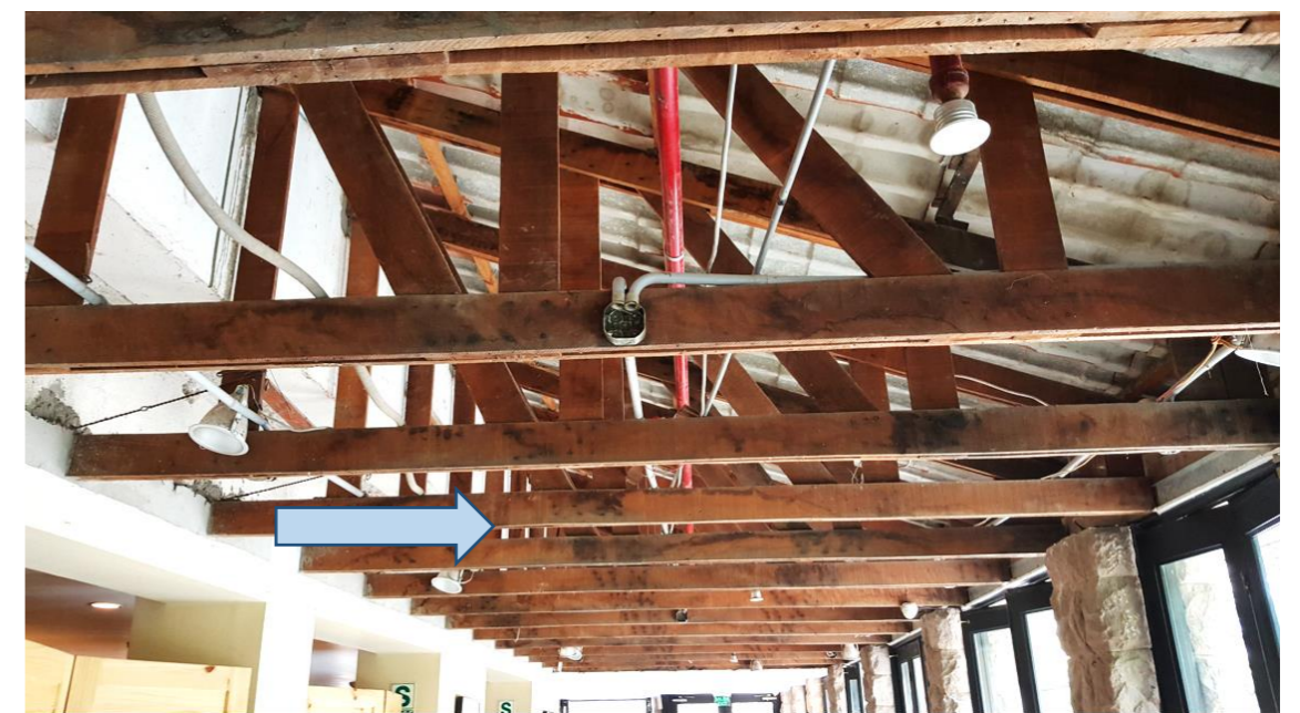
Figura 18: Desmontaje concluido de falso cielo raso de etapa 1.
