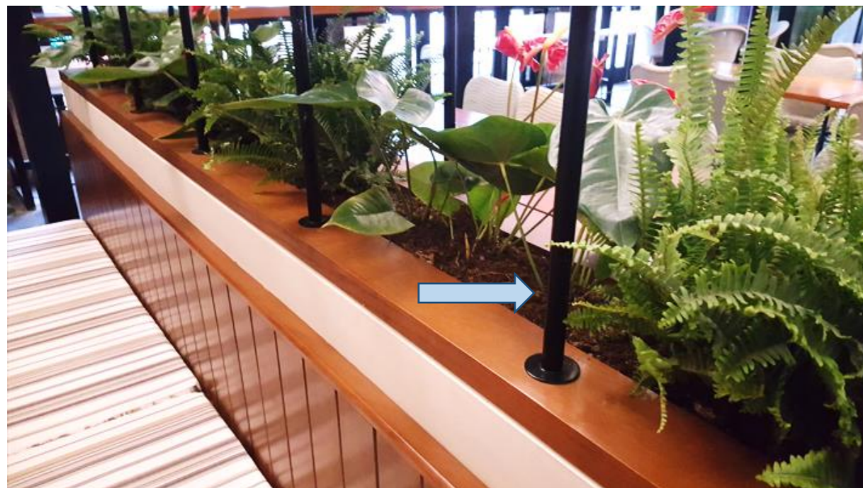
Figura 50: Jardineras con detalle de bancas, instalado de tubos metálicos de 1/2" para sostener jardineras flotantes.
