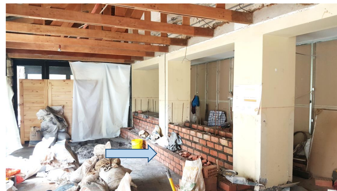
Figura 21: Armado de muro divisorio y para poyo de banca.
