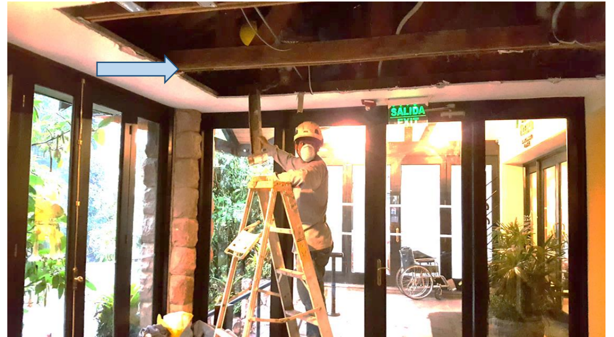
Figura 17: Desmontaje de falso cielo raso de restaurante.
