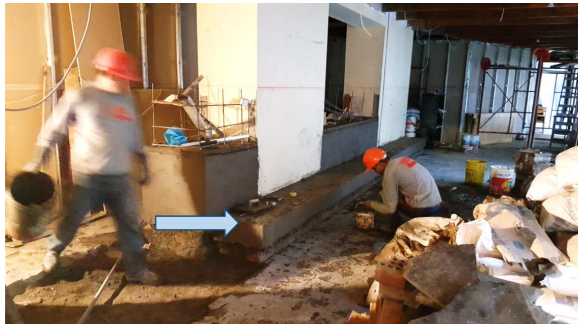
Figura 23: Tarrajeo de bancas y divisiones en jardineras.
