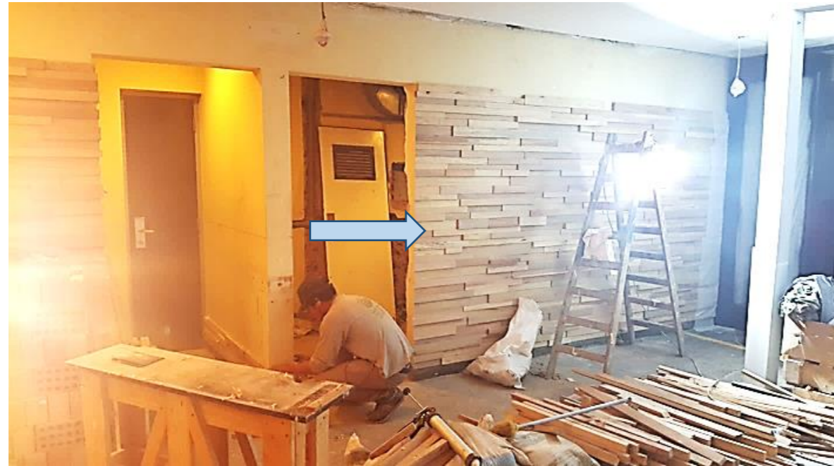
Figura 34: Enchape de muro con madera reciclada de diferentes medidas.
