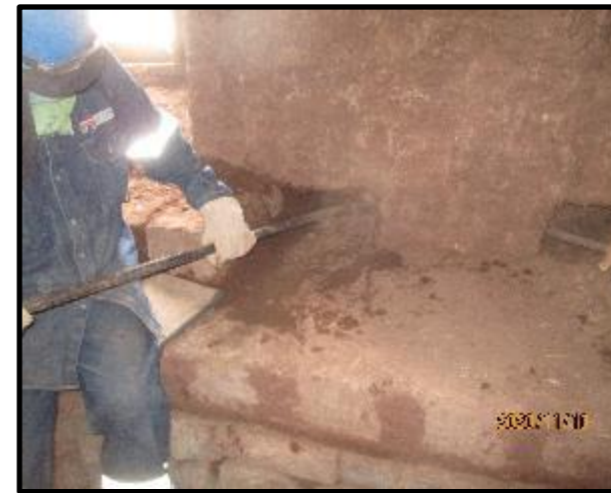
FIGURA 40: MURO TESTERO DELGADO EXISTENTE
