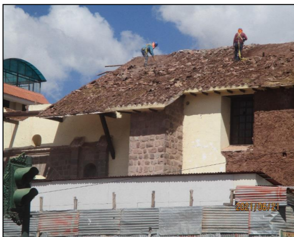
FIGURA 59: DESMONTAJE DE TEJAS COLONIALES
