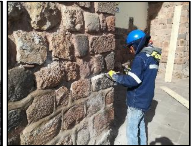
FIGURA 29: CALZADURA DE MUROS DE PIEDRA
