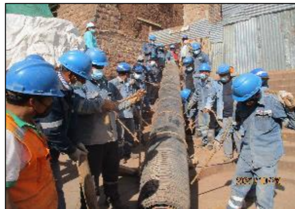
FIGURA 66: ACARREO DE GEOMEMBRANA PARA REALIZACIÓN DE CORTES
