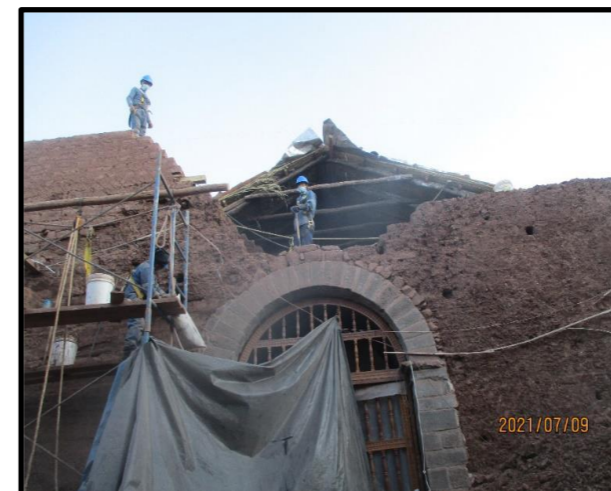
FIGURA 48: DESMONTAJE DE MURO EPÍSTOLA
