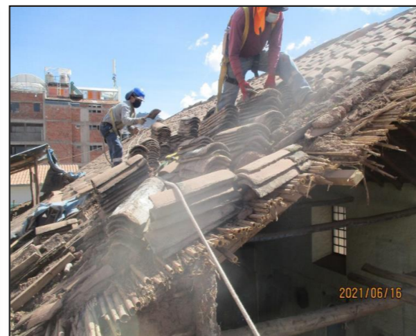
FIGURA 60: DESMONTAJE DE ENCARRIZADO Y ESTRUCTURAS
