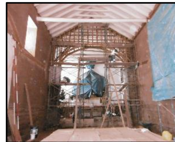
FIGURA 36: ARMADO DE ESTRUCTURA DE ARCO
