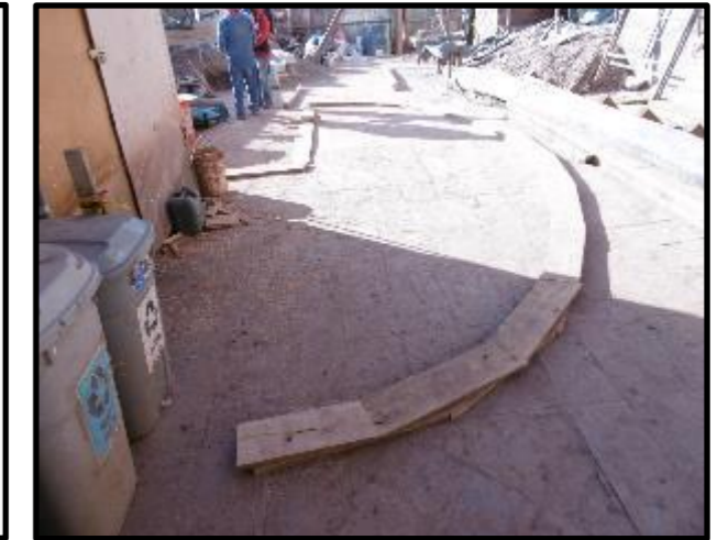
FIGURA 35: ARMADO DE CERCHA
