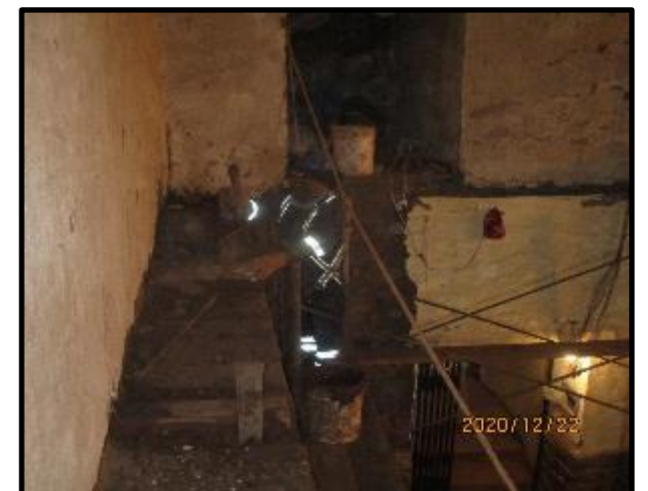
FIGURA 43: COLOCACIÓN DE LLAVE MURO TESTERO
