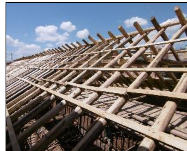
FIGURA 63: RESTITUCIÓN DE PARES Y NUDILLOS, COLOCACIÓN DE CORREAS
