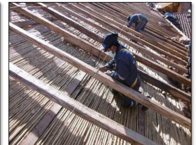
FIGURA 64: RESTITUCIÓN DE SOBREPARES SOBRE ENCARRIZADO DE FALDONES INTERIORES
