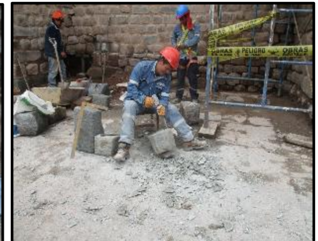
FIGURA 31: LABRADO DE PIEDRA PARA CALZADURA DE CIMIENTOS
