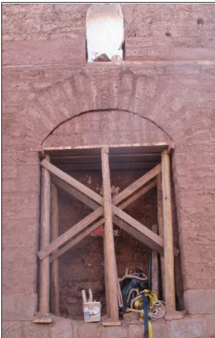
FIGURA 86: HORNACINA TAPIADA HALLADA EN MURO DEL EVANGELIO
