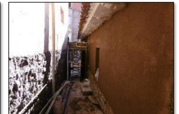
FIGURA 58: CONSOLIDACIÓN EXTERIOR BAPTISTERIO
