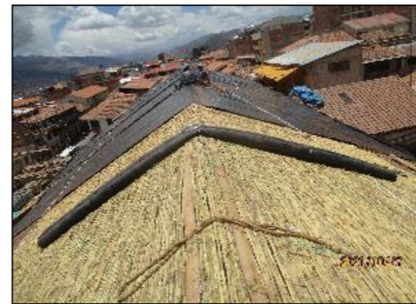
FIGURA 67: COLOCACIÓN DE GEOMEMBRANA
