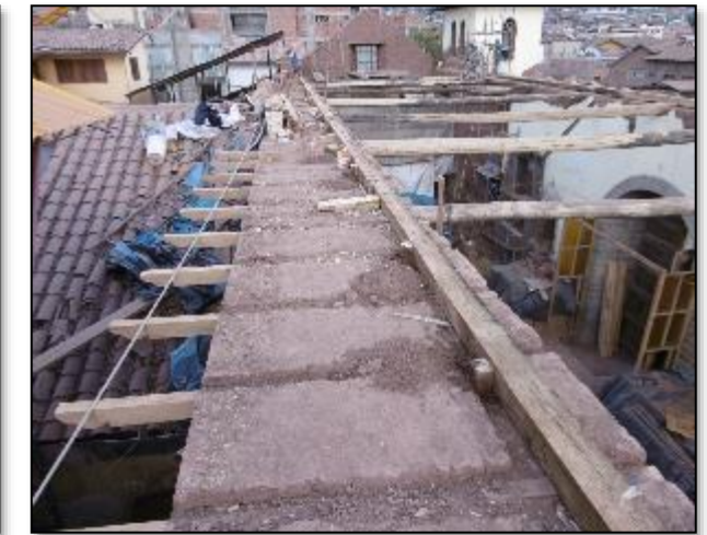
FIGURA 62: COLOCACIÓN DE CANES Y VIGAS ARROCABLES
