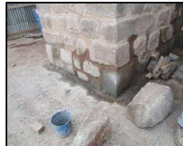
FIGURA 30: PIEZA RESTITUIDA Y EMBOQUILLADO DE MURO DE PIEDRA
