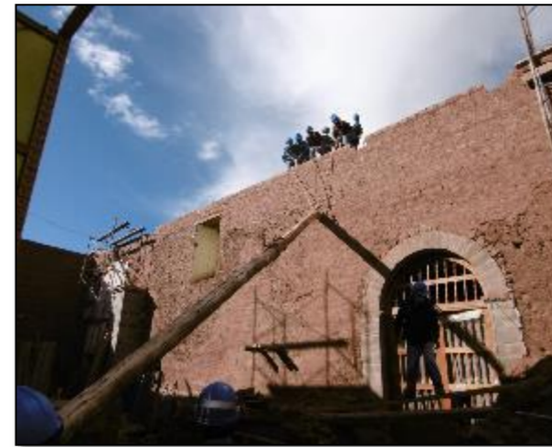
FIGURA 61: RESTITUCIÓN DE TIRANTES – TRABAJO DE MAYOR RIESGO POR EL PESO DE LOS ROLLIZOS
