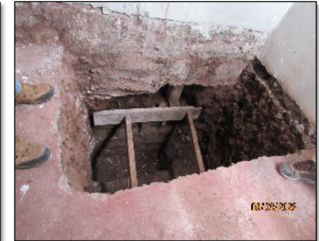
FIGURA 51: CALA EXPLORATORIA EXCAVADA EN PISO DE PROPIEDAD SRA. CARMELA BAYÓN
