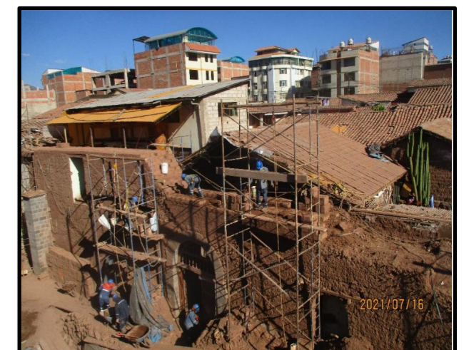
FIGURA 49: RESTITUCIÓN DE MURO EPÍSTOLA
