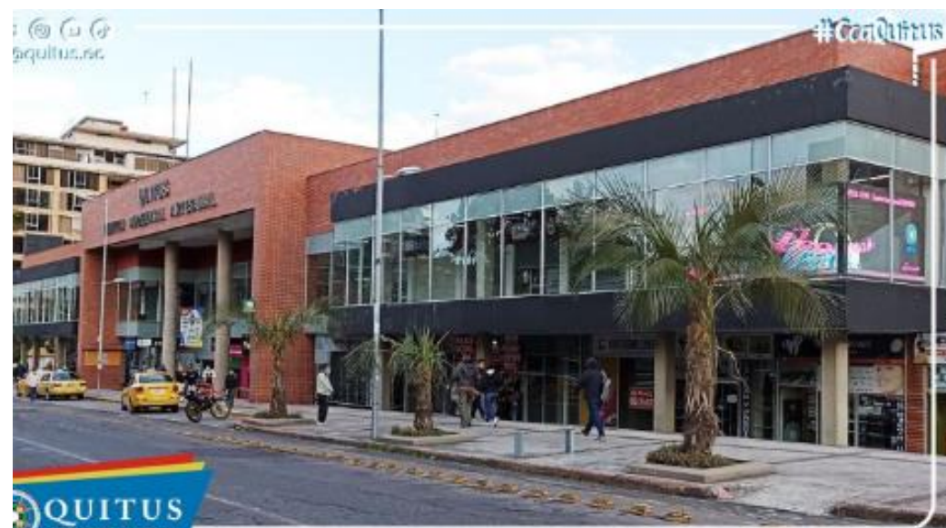
Figura N° 73: ingreso principal en ladrillo cara vista Fuente: Google
