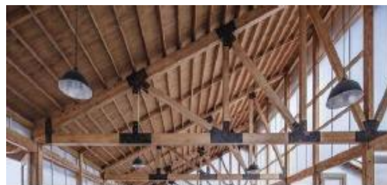
CUBIERTAS SOBRE ESTRUCTURAS METALICAS COLOR MADERA
