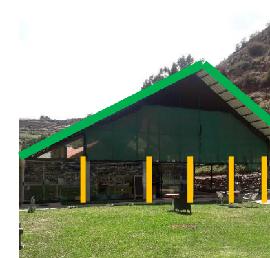
Figura N° 59: Imagen de la estructura metálica sobre columnas de concreto.
