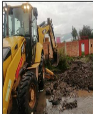
Trabajos de limpieza
