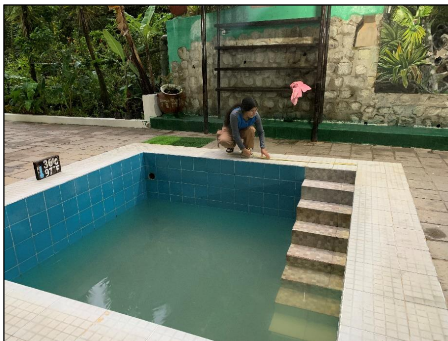
Figura 115. Medición del largo de la piscina N°6.
