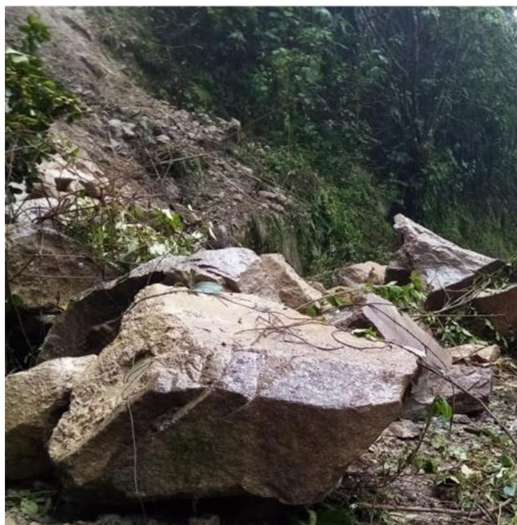
Figura 103. Caída de roca aguas arriba del balneario.
