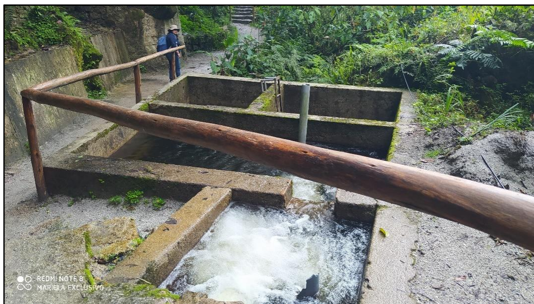
Figura 117. Captación de aguas superficiales.
