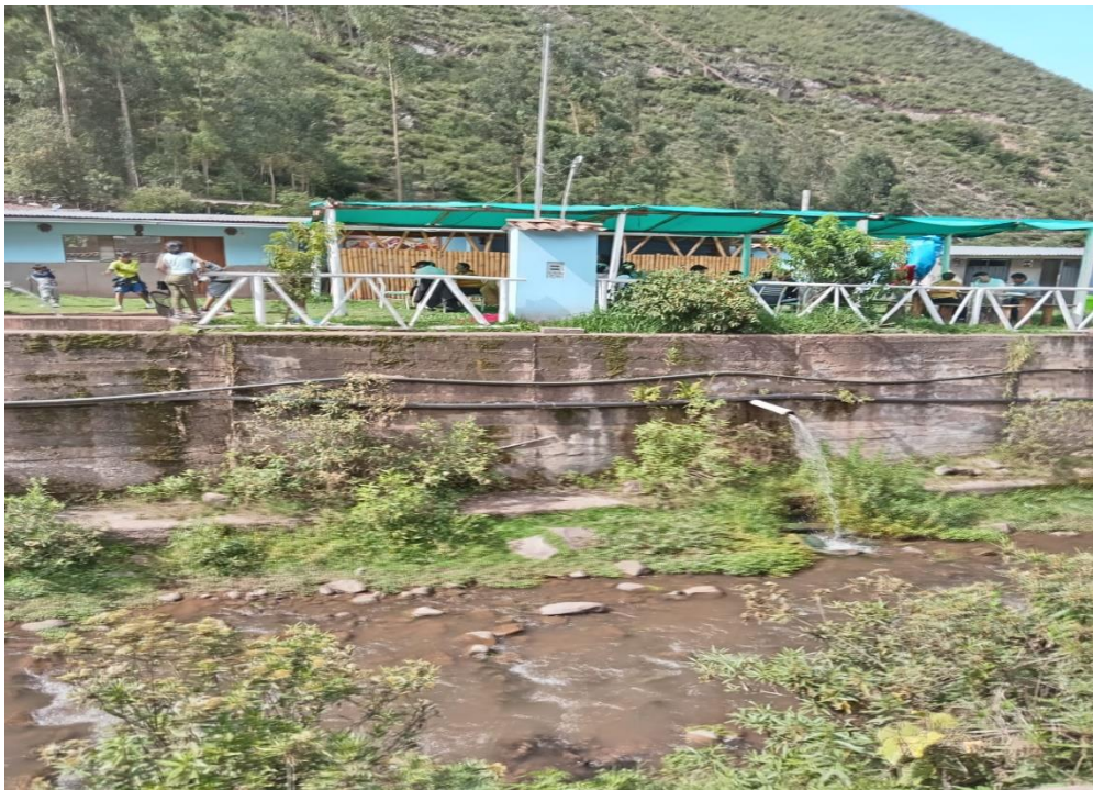
Figura. 28 Tubería instalada hacia el río.
