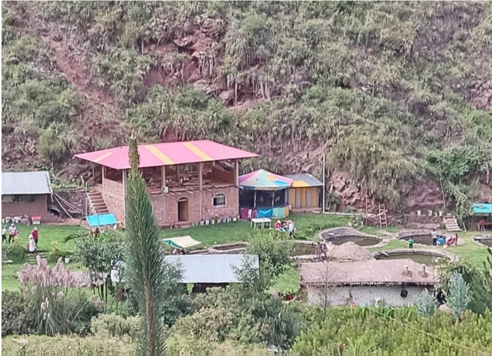
Figura. 8 vista externa de una piscigranja.
