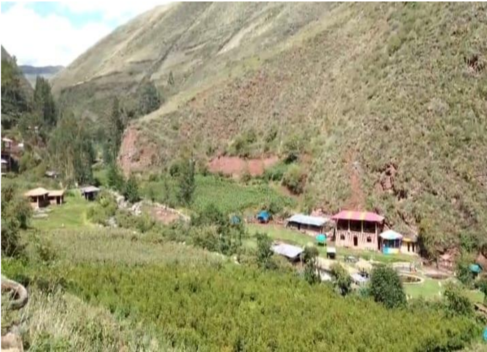
Figura 21. Construcción de Piscigranjas al borde del río.
