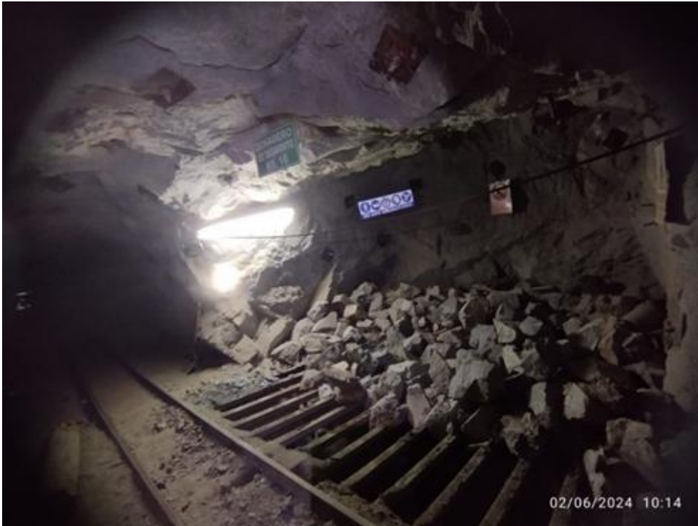
Figura 6 Tolvas de Transferencia
