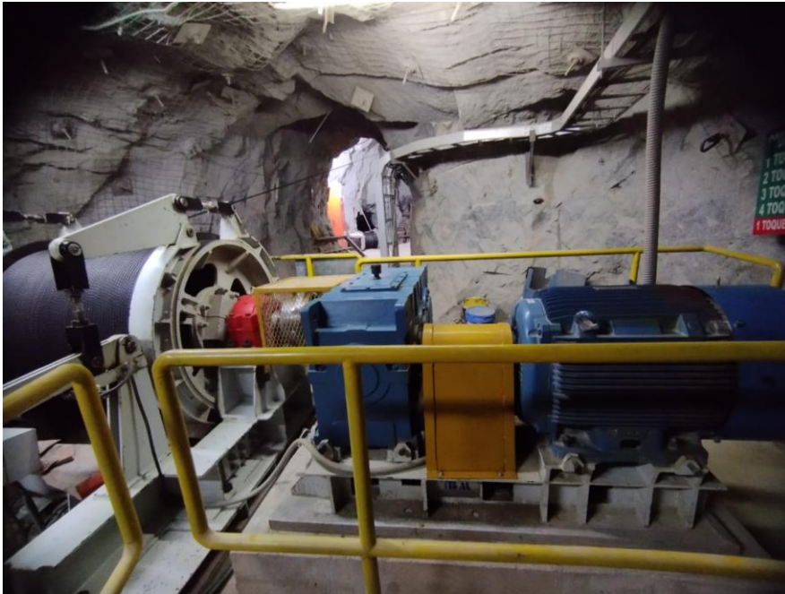
Figura 7 Control de izaje I
