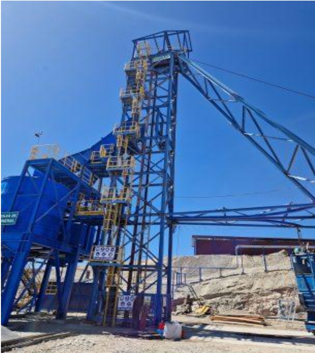
Figura 2 Cable de Izaje PQ Salvador
