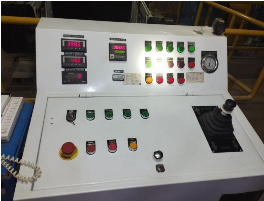
Figura 8 Control de izaje II
