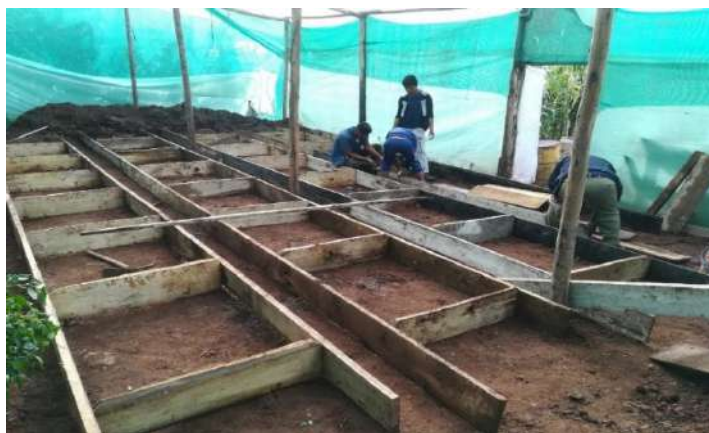
Fotografía N°09: Utilización de tablas y armado de cajas para las parcelas.
