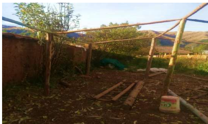
Fotografía N°01: Construcción de fitotoldo.
