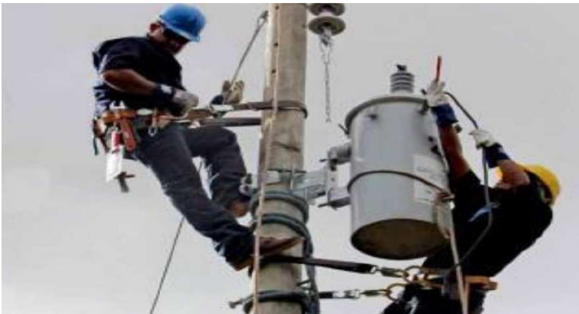
Instalación de transformador en poste
